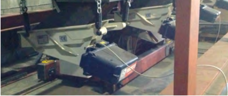
Demirli alaşım tesisleri
